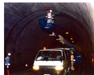
トンネル覆工背面調査
